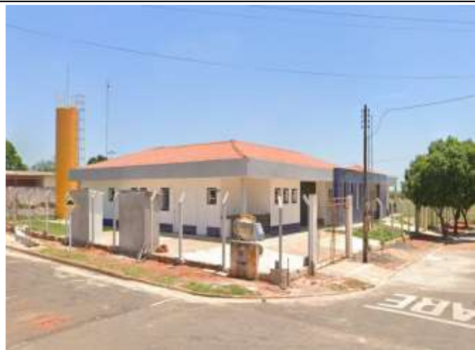
Figura 01: Local: Creche Proinfância.
