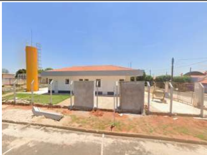
Figura 02: Local: Creche Proinfância.
