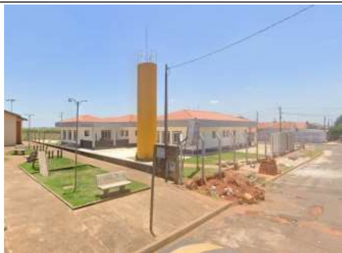
Figura 03: Local: Creche Proinfância.
