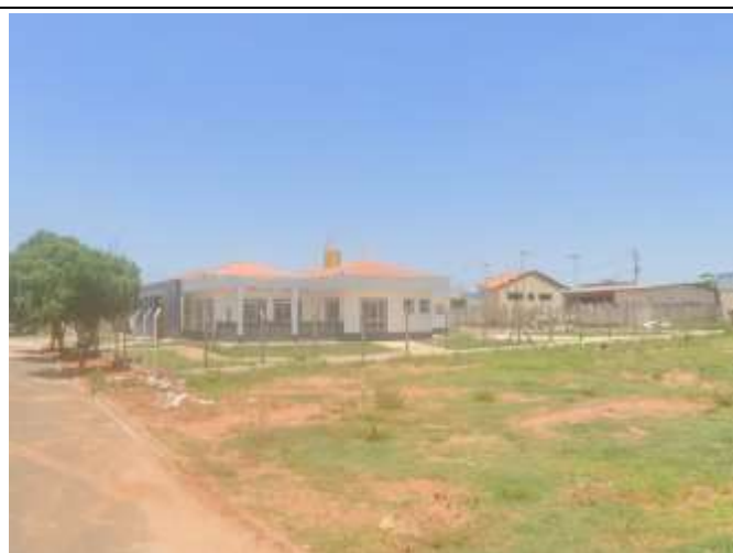
Figura 04: Local: Creche Proinfância.
