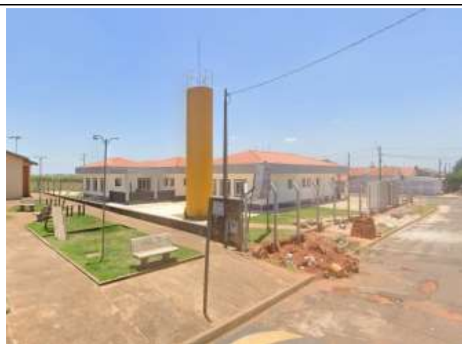
Figura 03: Local: Creche Proinfância.
