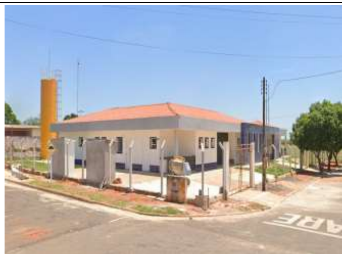
Figura 01: Local: Creche Proinfância.
