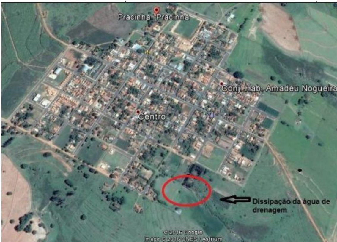
Figura 21: Área degradada pelo lançamento de águas pluviais, na sub-bacia 2 (Ribeirão dos Macacos)
